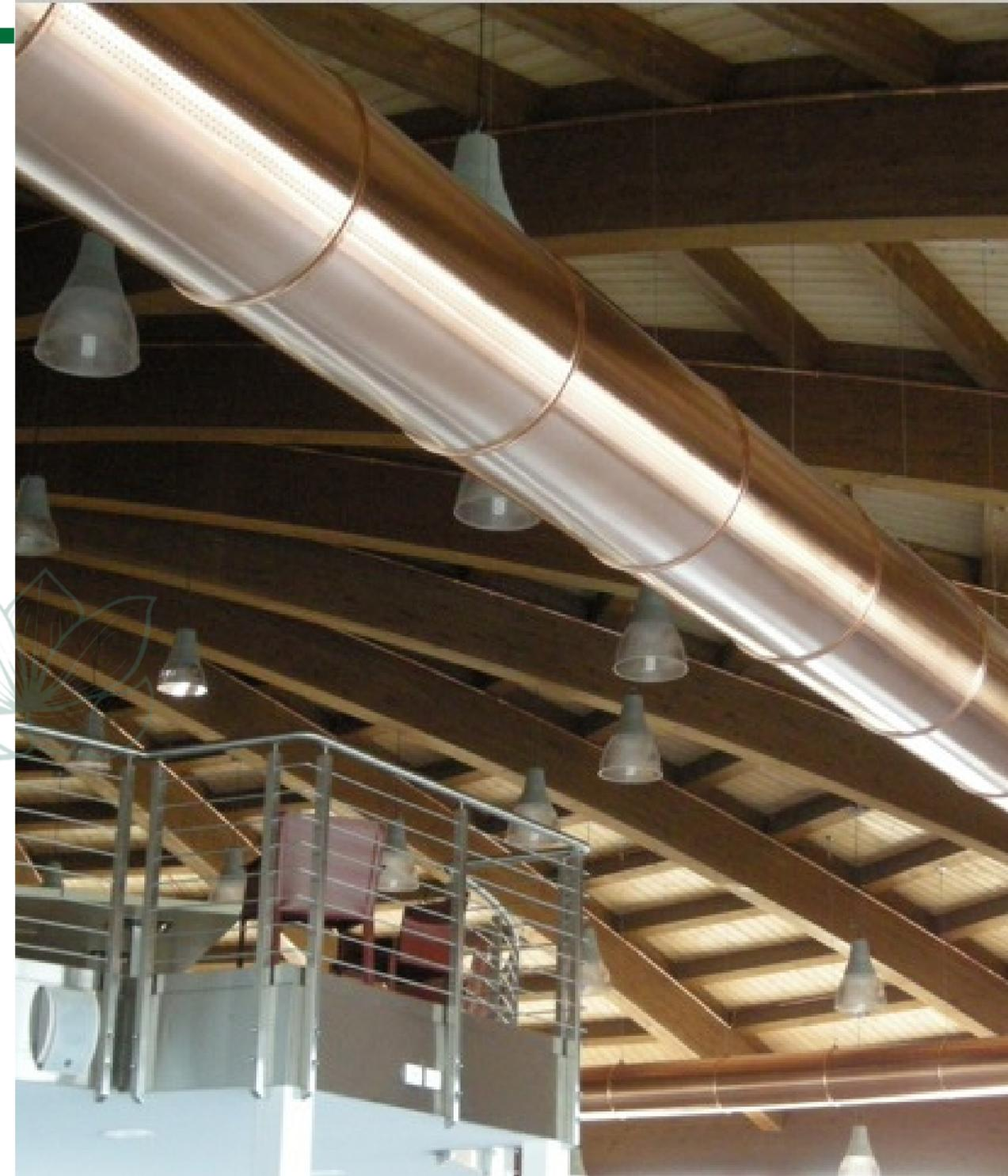
I diffusori metallici METALjet sono disponibili in sezione circolare con diametri da 200 a 1500 mm e a sezione semicircolare con diametri da 200 a 1000 mm.
