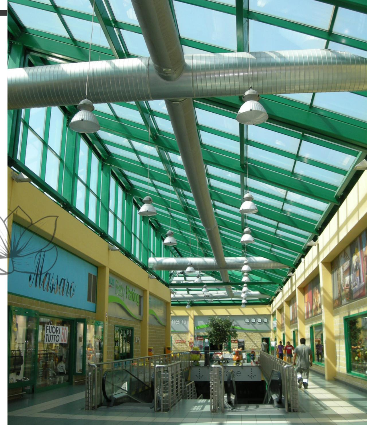
Progettato con tessuti composti da fibre inorganiche, questi diffusori garantiscono la massima igiene e offrono il grande vantaggio della leggerezza, pesando meno sulle strutture portanti dell'edificio rispetto agli altri impianti di distribuzione dell'aria. Grazie alla tecnologia laser, si può definire la forometria ottimale per ogni soluzione.
